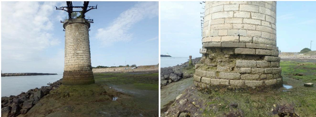
Figure 14 : Maçonnerie de la Tourelle T12-N en bon état (à g.) et de la tourelle T14-N en mauvais état (à d.) - (cf Annexe 5) – Source ANTEA (2019)
