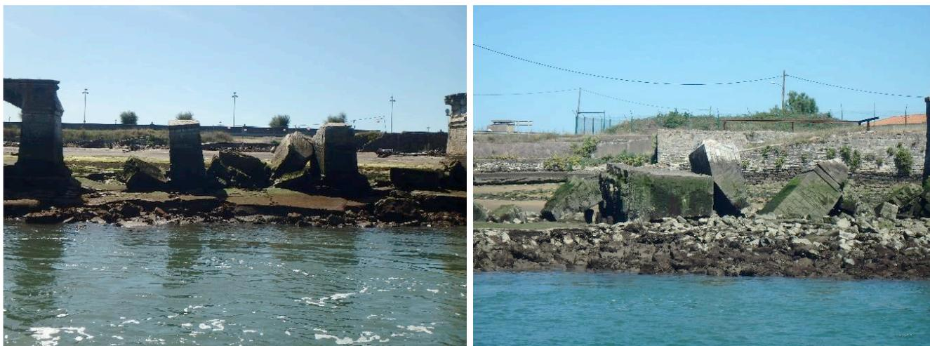
Figure 17 : Piles PA6-S et PA7-S (à g.) et PA2-N et PA3-N effondrées (à d.) (cf Annexe 6 pour localisation) – Source ANTEA (2019)
