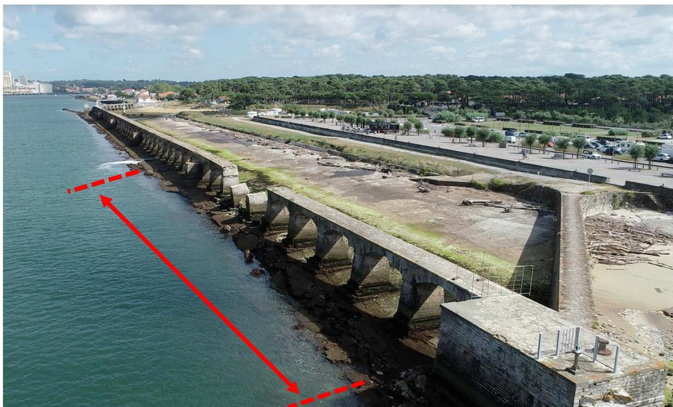
Figure 10 : Section de viaducs en rive Sud déficiente en enrochements de protection – source CASAGEC (2019)
