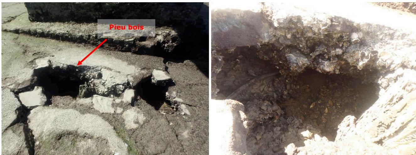
Figure 13 : Cavités et sous-cavage associés au droit de la pile PD9-S (cf Annexe 5) – Source ANTEA (2019)
