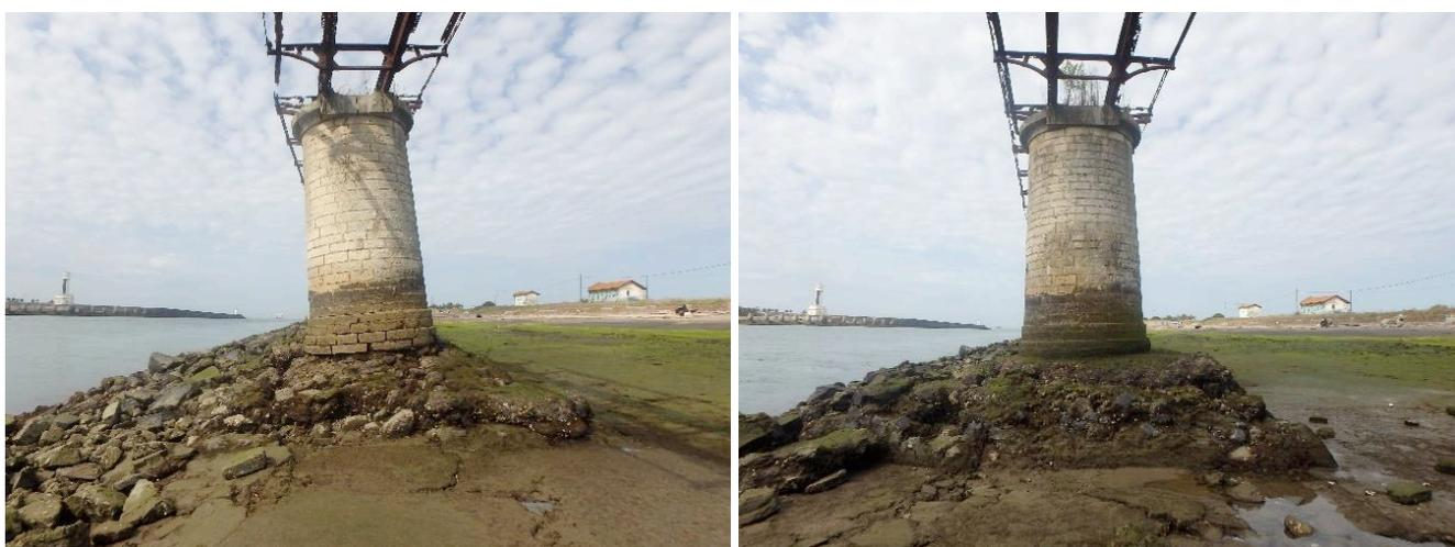
Figure 16 : Tourelles T20-N (à g.) et T21-N (à d.) inclinées vers l'Adour (cf Annexe 6 > ouvrage en état critique) – Source ANTEA (2019)
