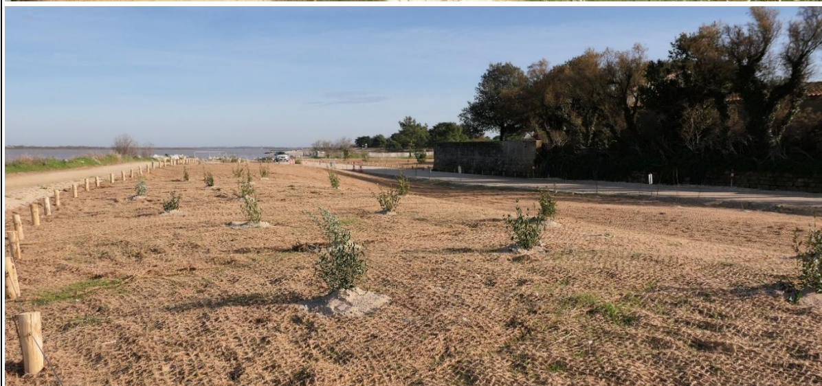
Pointe du Calvaire, Port-des-Barques - Travaux réalisés en 2025-2026
