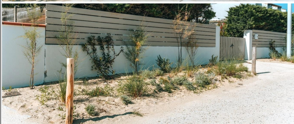
Plan plage de l'Horizon, Lège-Cap-Ferret - Travaux réalisés en 2024
